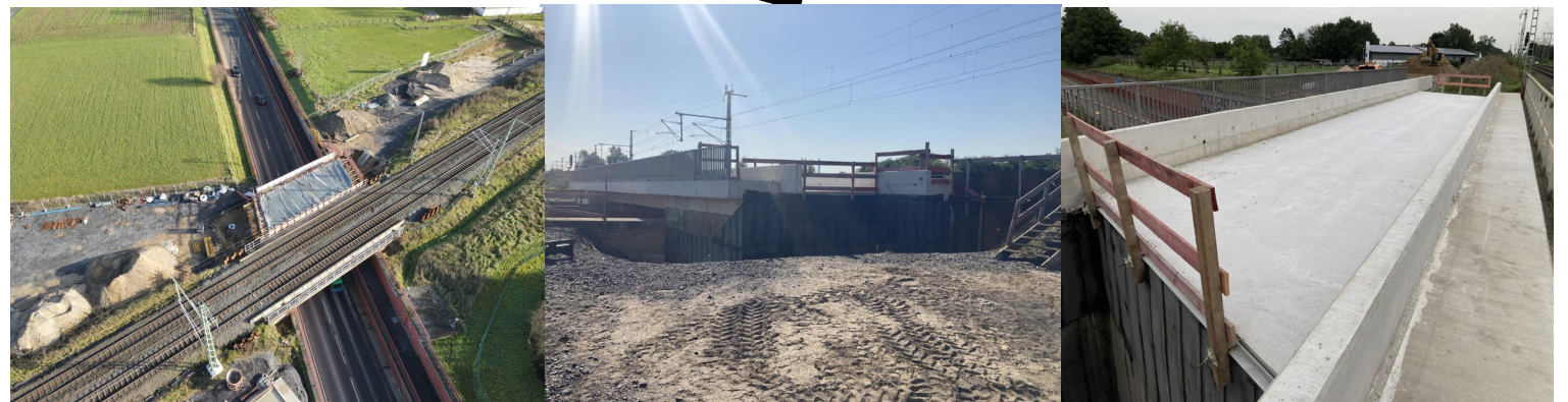
Erweiterung der Eisenbahnüberführung Hammweg bahnrechts für das neue 3. Gleis
