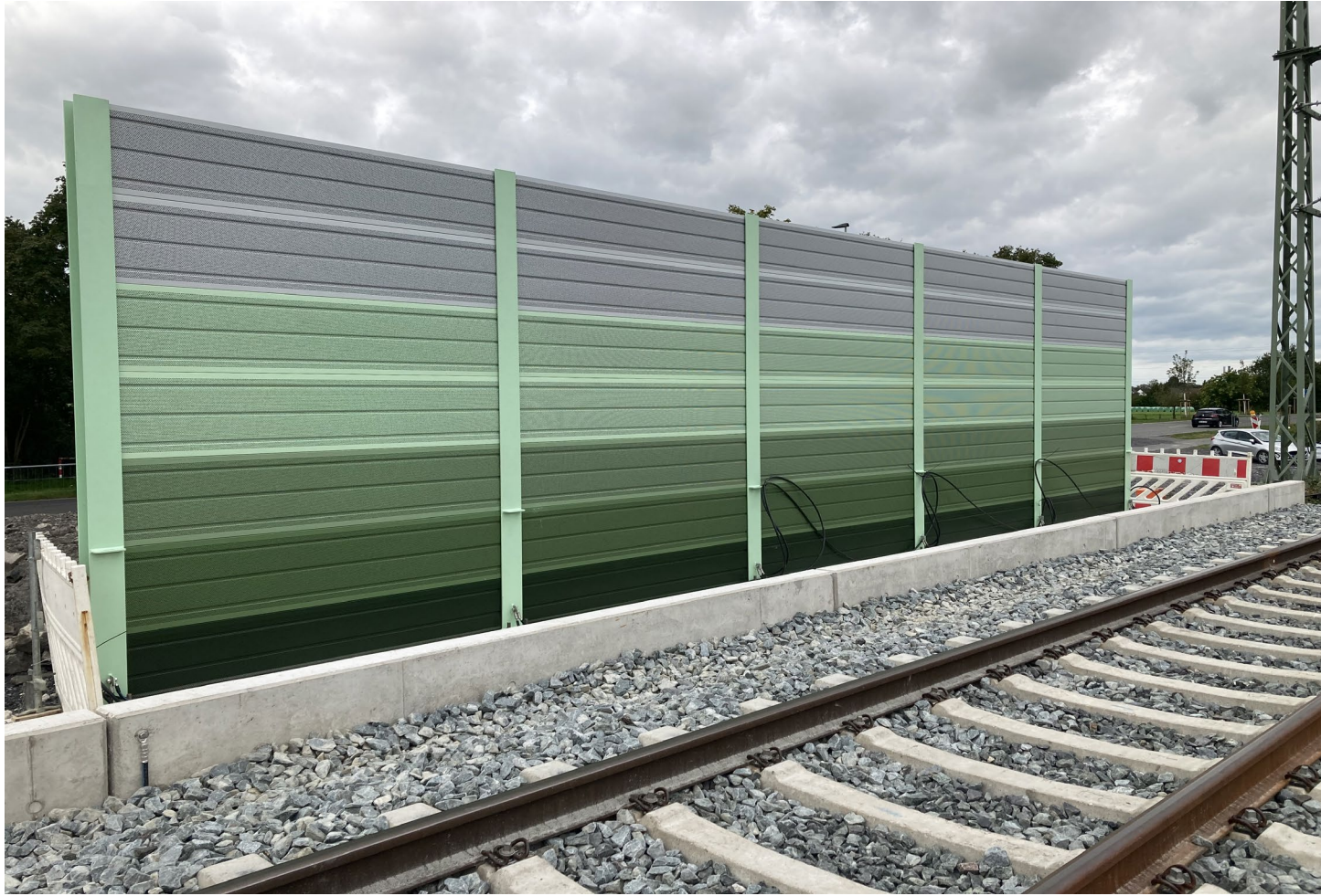
Lärmschutzwand auf der Eisenbahnüberführung Holthausen Bach/Mommbach
