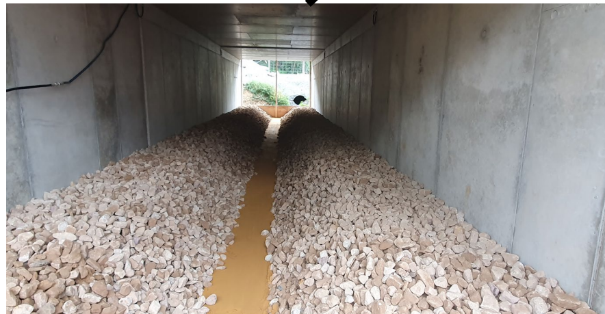
Eisenbahnüberführung Holthäuser Bach / Mommbach
