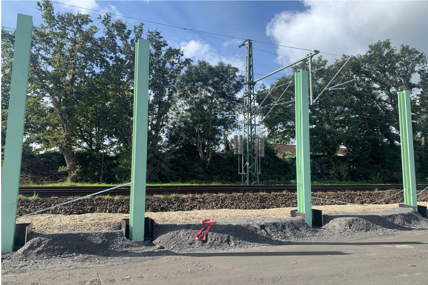
Lärmschutzwandpfosten entlang der „freien“ Strecke im Bereich des HP Voerde
