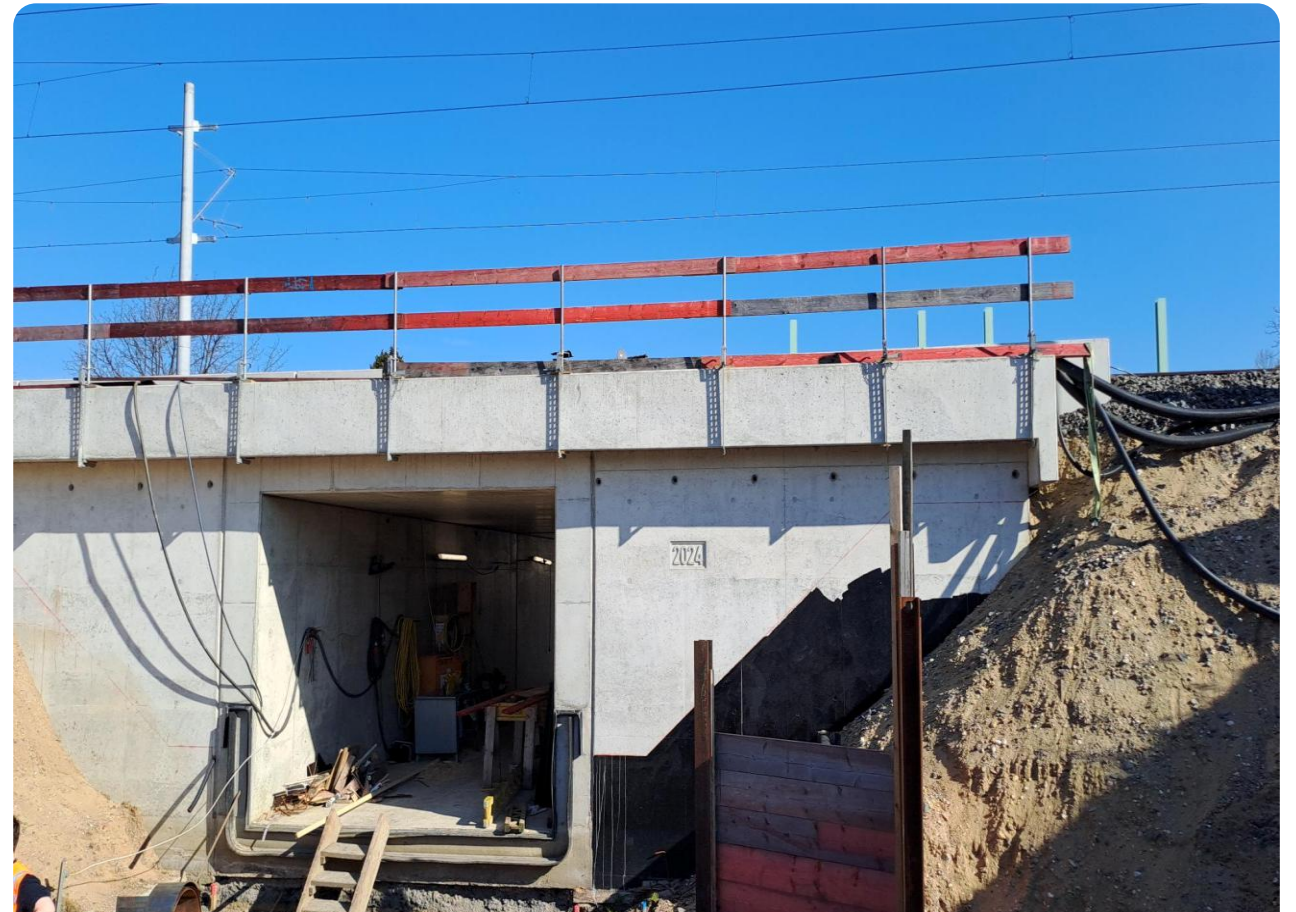
Ansicht Süd von der Eisenbahnüberführung
