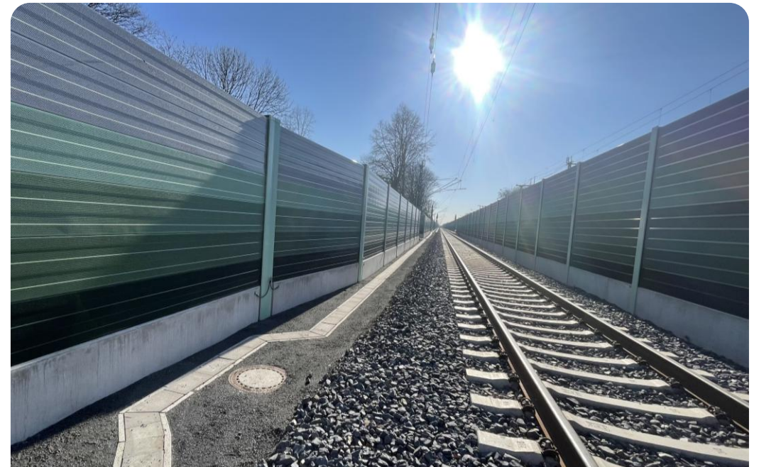
Schallschutzwand in Voerde
