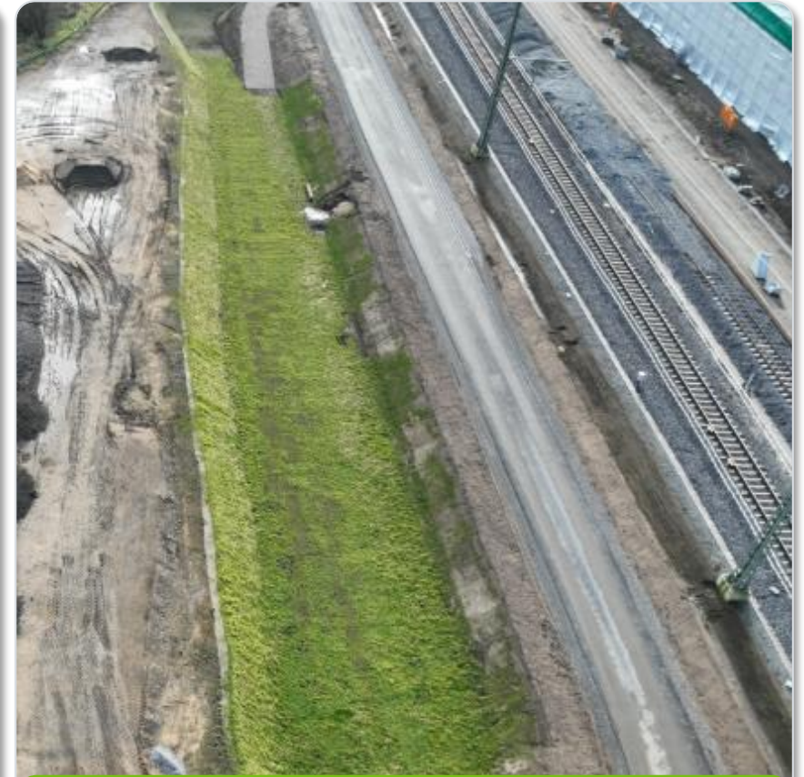
Hergestelltes Versickerungsbecken und Rettungsweg/Kasselweg (Blickrichtung Voerde)
