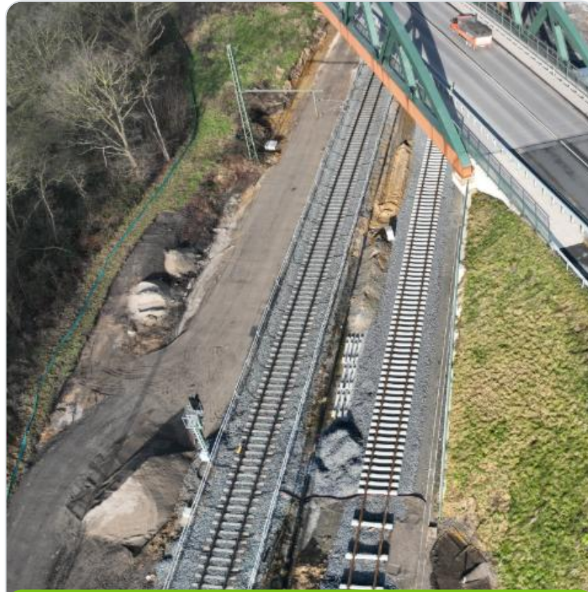
Bereich Herstellung 3-Gleisigkeit und Bodenverbesserung (Blickrichtung Wesel)
