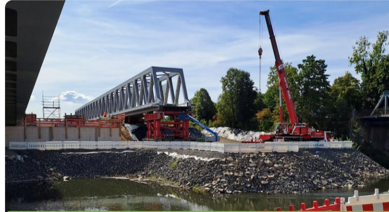
Einfahren des zweiten Überbaus
