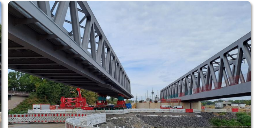
Einfahren des zweiten Überbaus
