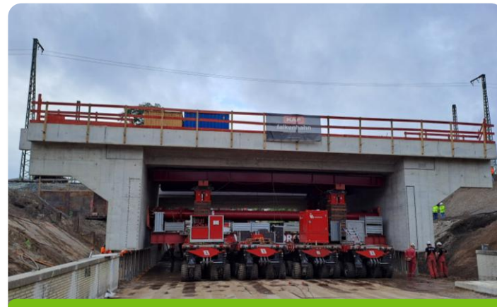
Einfahren der neuen Brücke
