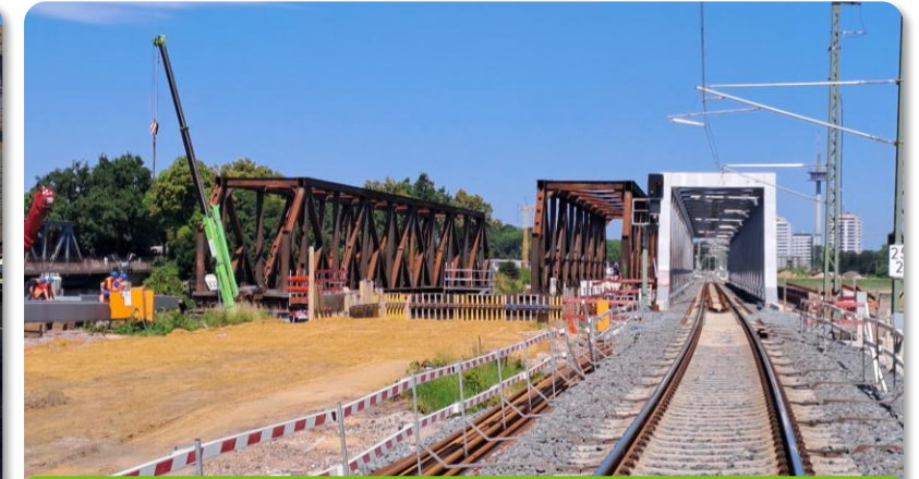
Ausfahren der alten Brücken
