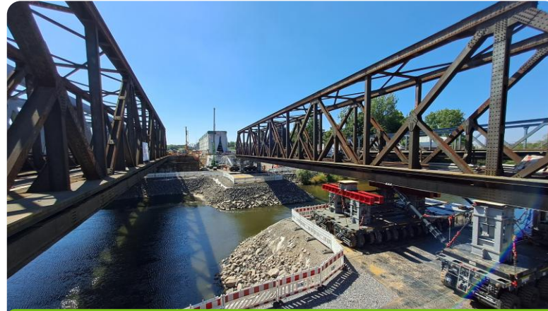
Ausfahren der alten Brücken
