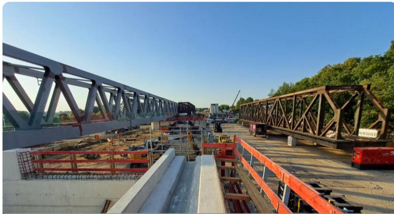
Ausgefahrene Brücke
