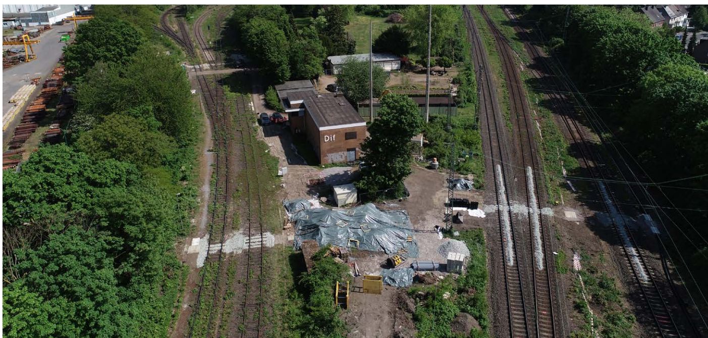
Kabelquerungen im Bereich Dinslaken
