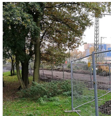
Errichtung von Schutzzäunen für ältere Baumbestände
