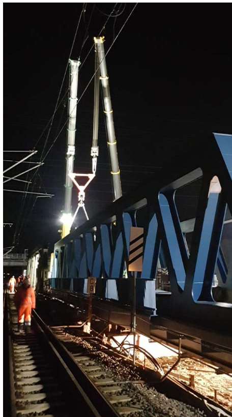
Brückeneinschub über der Emscher
