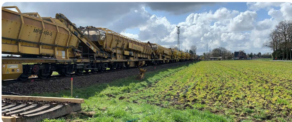
Ein Gleisumbauzug ermöglicht den kontinuierlichen Umbau von Gleisen.
