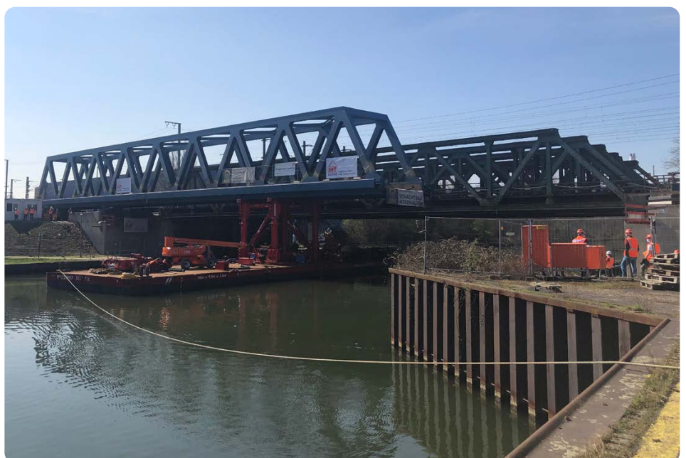
Für den Brückeneinschub wurden Schwimmpontons eingesetzt.
