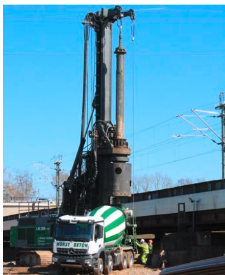
Großbohrgerät mit Betonmischer für die Herstellung von Bohrpfehlen, wie sie beim Bau der EÜ „Bahnhofstraße“ und dem Straßentrog zum Einsatz kommen werden.
