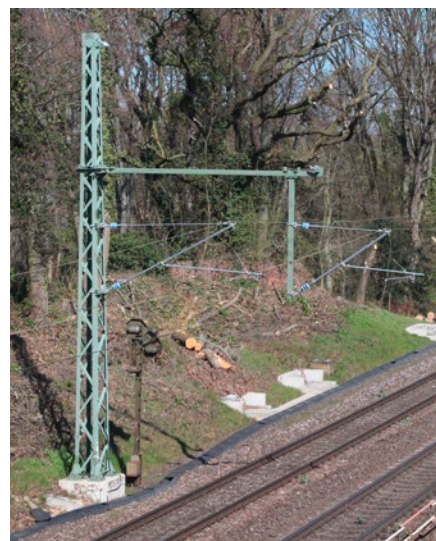
Die bestehende Oberleitungsanlage in Haldern wird zur Baufeldfreimachung mit Mehrgleisauslegern umgebaut.
