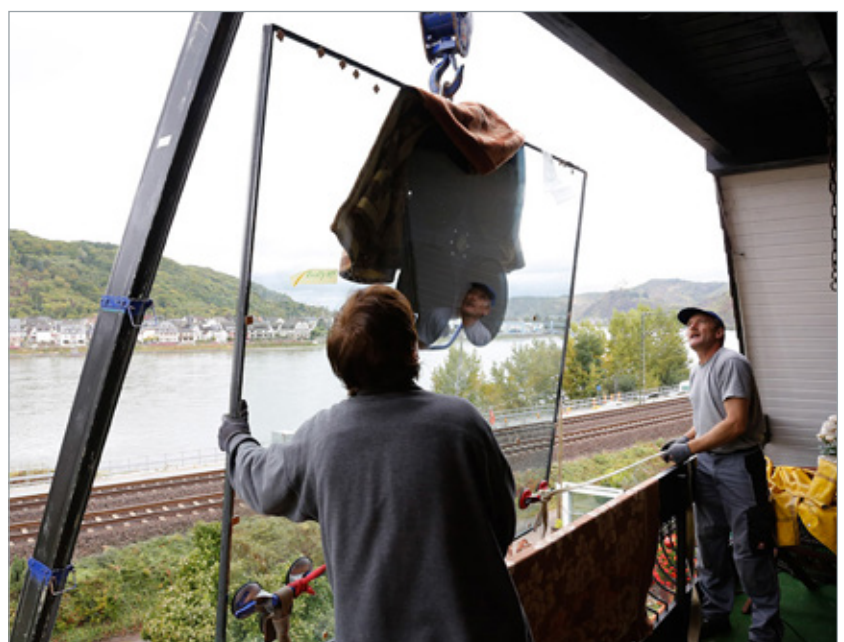
Einbau von schalldämmenden Fensterscheiben in einem Fachwerkhaus am Mittelrhein
