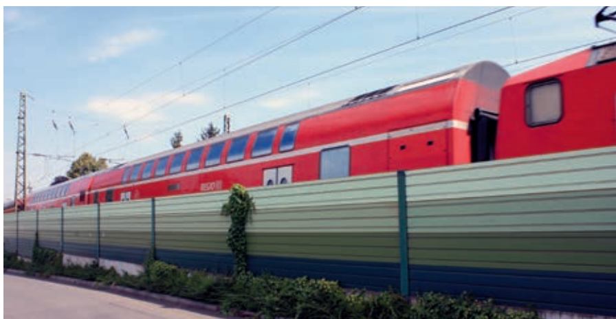
Beispiel einer Schallschutzwand
