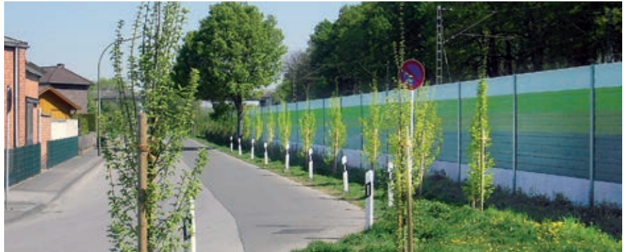
Beispiel einer Schallschutzwand
