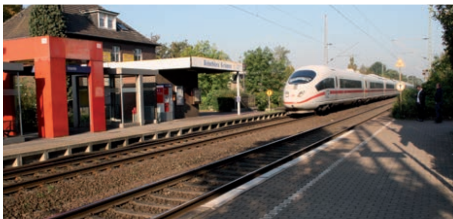
Der Haltepunkt Voerde erhält zwei neue Außenbahnsteige, das Mittelgleis bleibt ohne Bahnsteig.
