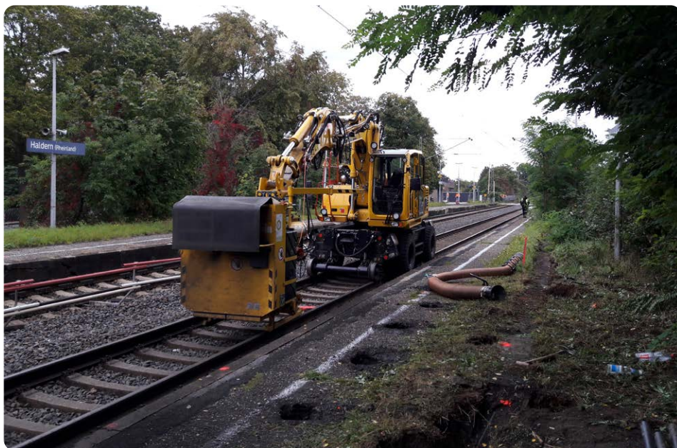
Vegetationsarbeiten entlang der Strecke
