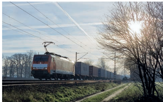
Das Projekt Ausbaustrecke Emmerich-Oberhausen umfasst mehrere Umsetzungsstufen, zentraler Bestandteil ist der dreigleisige Ausbau der Strecke
