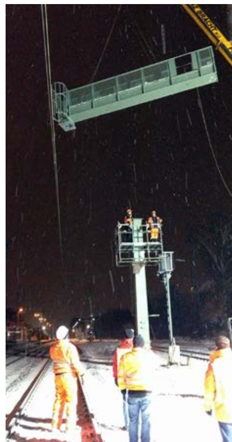
Ein neuer Signalausleger wird eingebaut.
