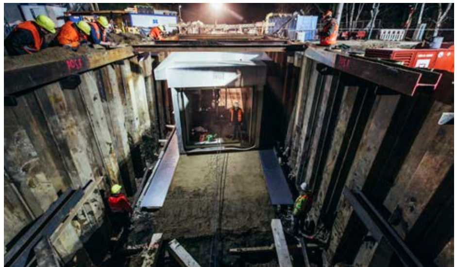
In einem 5-minütigen Arbeitsgang wurde das Rahmenbauwerk für die EÜ(F) Rahmstraße am Ostersamstag eingeschoben.
