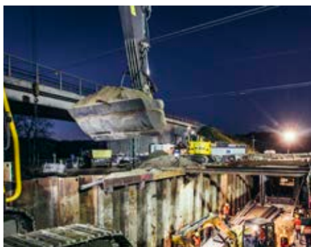
Bauarbeiten an der EÜ(F) Rahmstraße
