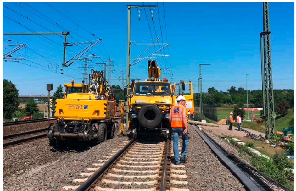
Im PFA 1.1 (Oberhausen) rollen bereits die Bagger. Aktuell laufen die Bauarbeiten an den Eisenbahnüberführungen „Rhein-Herne-Kanal“ und „Lindnerstraße“.
