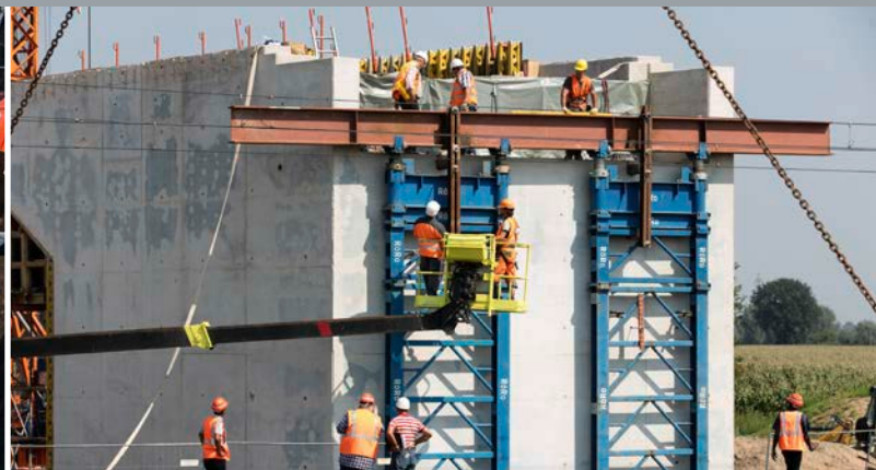
... und das Brückenbauwerk an der Baumannstraße eingehoben.
