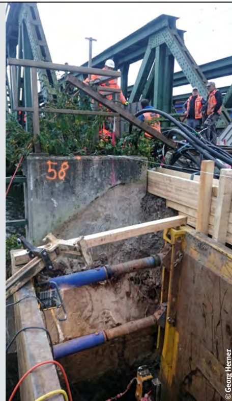
Zwischen Brücke und Erde befinden sich die Widerlager. Die müssen hier erneuert werden.
